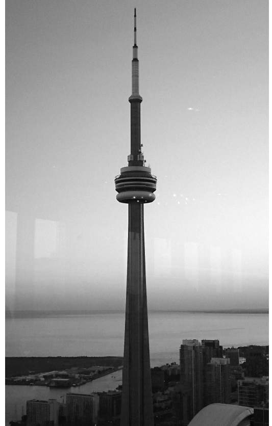
写真2 トロントのCNタワー
